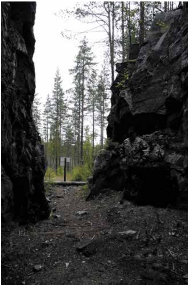
Salpalinjan aikainen luolan suuakko, jonka puiset asemarakenteet ovat lahonneet. Kuva on otettu ampumasuuntaan. Varsinainen suojavaikka oli louhittu kallion vasempaan reunaan.
