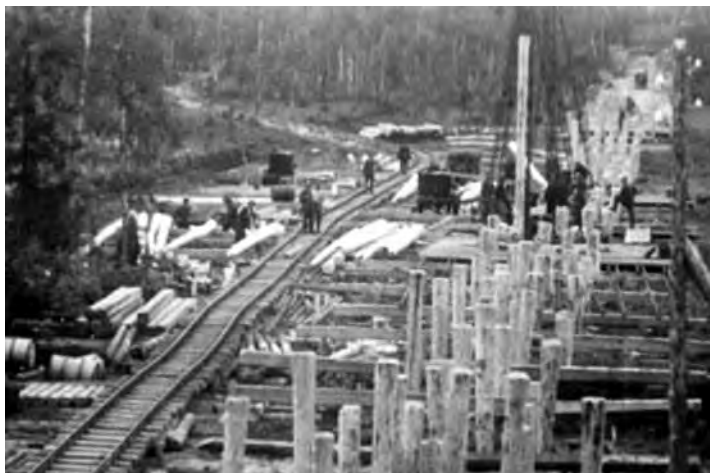
Junnosuo suosilta. Pehmeään maastoon jouduttiin lyömään satamäärin paaluja, joita työn tehneet venäläiset sotavangit junnuttivat 6 – 7 hengen porukoissa. Työ oli raskasta ja ravinto heikkoa, joten vankeja kuoli ratatyömaan aikana useita satoja. Vankien joukkohautapaikkoja on yhä vieläkin nähtävissä pitkin radan vartta. Tämän vuoksi kenttärata sai paikalliselta väestöltä nimityksen Kuolemanrata.
