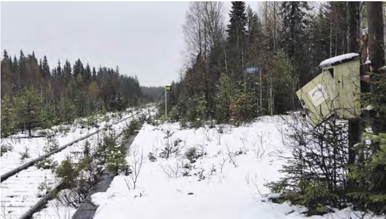
Sodan jälkeen saksalaisten kenttäradan pohjaa käytettiin monin paikoin maanteiden rakentamiseen, mutta kovemilla maapohjilla sitä voitiin käyttää leveäraiteiseksi rakennettuna esim. puutavarakuljetuksiin, kuten täällä Vääkiön aseman alueella.
