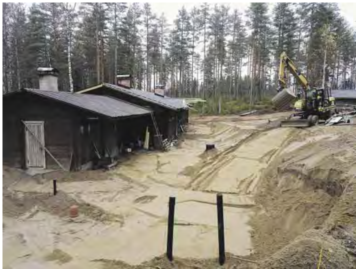
Erilaiset putket ja kanavat ovat saaneet maapeitteen.
