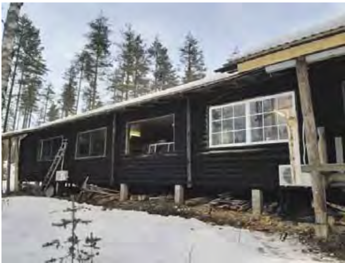
Lammenpuoleinen seinä saa uudet ikkunat.
