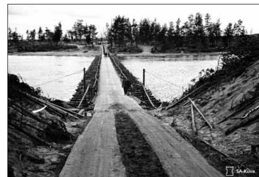
Ponttonisilta Vuosalmelta Äyräpään elokuussa 1941. SA-kuva
