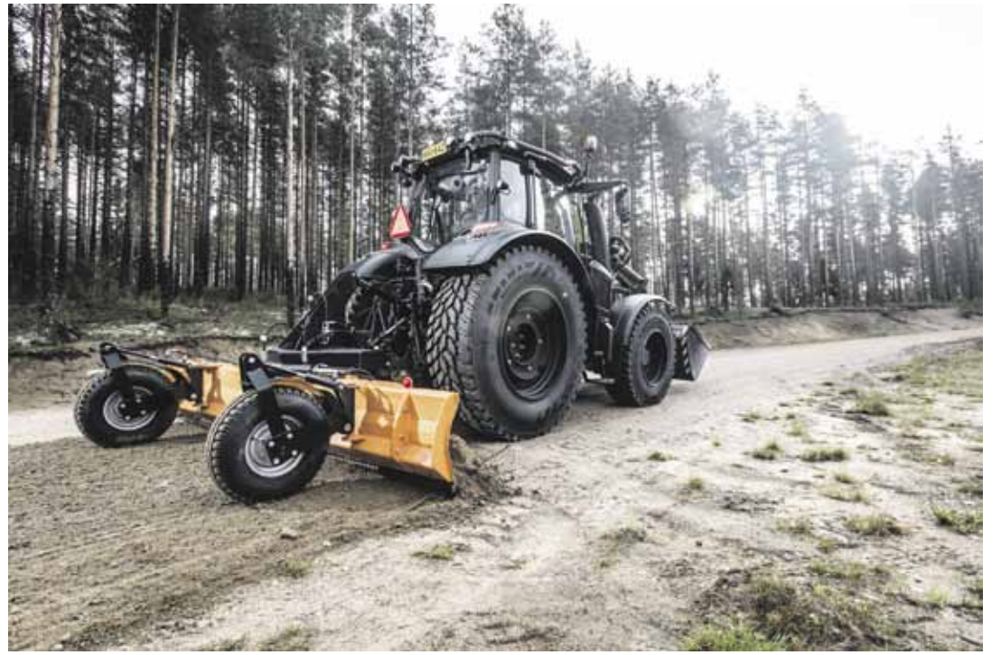
Tielanalla parannetaan huoltotien pintaa.
