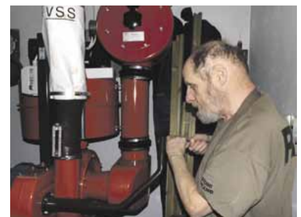
Kurssilla käsiteltiin myös väestönsuojan kuntoon laittoa. Korpilahden turvallisuuspäällikkö Pertti J. Louni testaa väestönsuojan ilmastointilaitetta. Korpilahden kirkolla on vain muutamassa kiinteistössä väestönsuoja, joten poikkeusoloissa korostuu suojautuminen omassa kodissa.
