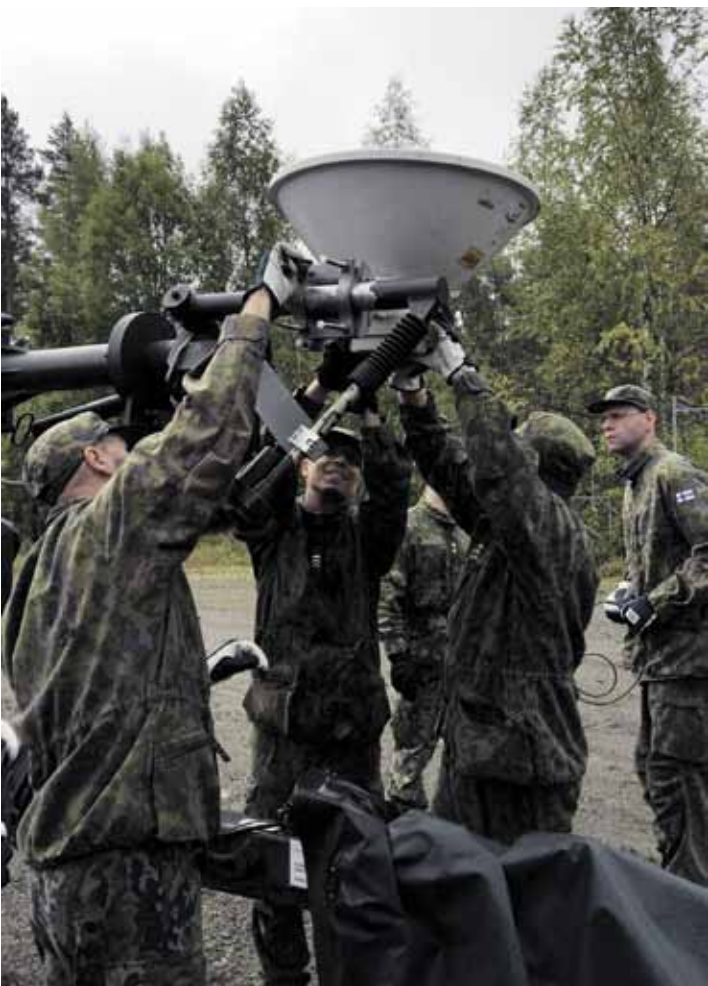
Tutkakaluston asennus käynnissä.
